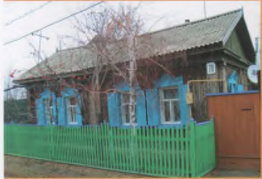
Дом семьи Бархатовых в селе Иртыш Черлакского района Омской области. Современный вид
