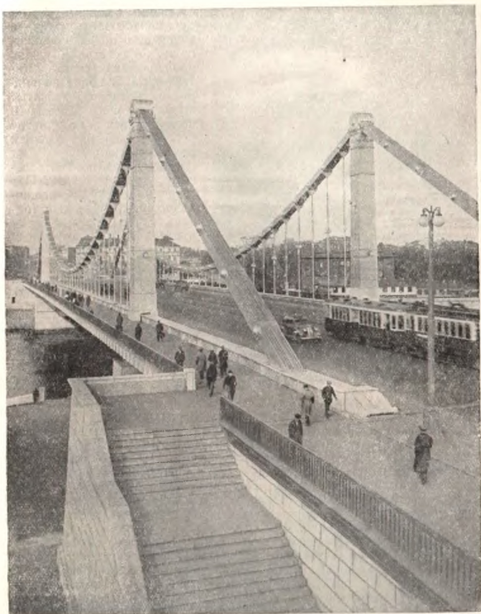
Новый Крымский мост через Москва-реку. Слева — гранитная лестница на мост со стороны набережной.
