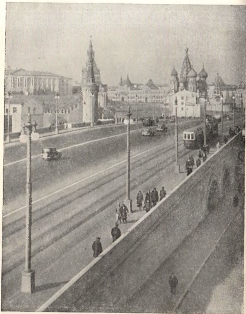
Новый Москворецкий мост через Москва-реку. Вдали видны храм Василия Блаженного, въезд на Красную площадь и кремлевские стены.
