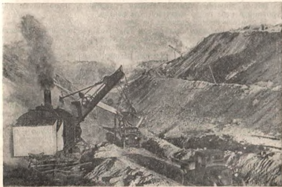
На стройке канала Москва — Волга. Мощные экскаваторы прорезают гряду холмов.
