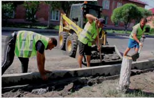
Ремонт 5-й Кордной по нацпроекту
