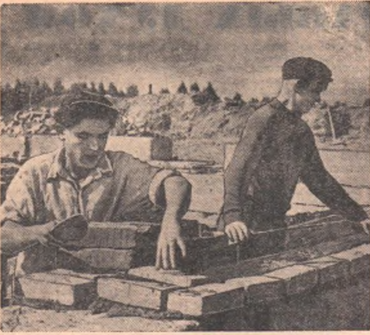
На пустыре, что в девяти километрах к западу от станции Куломзино, весной этого года началось строительство новой сортировочной железнодорожной станции «Приветная». Сейчас здесь идет сооружение жилых домов. Хорошо трудятся на новой строительной площадке каменщики колонны 145 строительно-монтажного поезда «Омсктрансстрой» молодой коммунист Михаил Морозов и комсомолец Владимир Ульянов, которых вы видите на нашем снимке. Их бригада соревнуется за звание коллектива коммунистического труда. Фото Г. Минаева.
