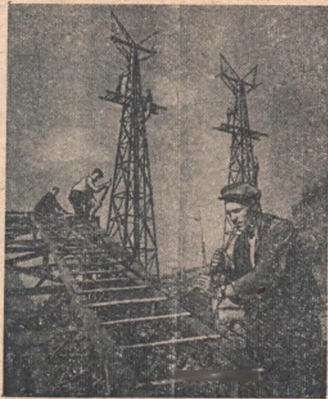
КУЙБЫШЕВГИДРОСТРОЙ. Мачты-опоры для подвесной дороги, которая соединит районы строительства Куйбышевской гидроэлектростанции, расположены на обоих берегах Волги. На переднем плане бригадир монтажников М. Соболев за сборкой узлов мачты-опоры. Фото Н. Финникова (Фотохроника ТАСС).
