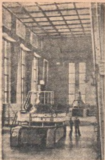
ПОЛЬСКАЯ НАРОДНАЯ РЕСПУБЛИКА. В г. Дыхове сооружается гидроэлектростанция. Недавно завершён монтаж второго турбоагрегата.
