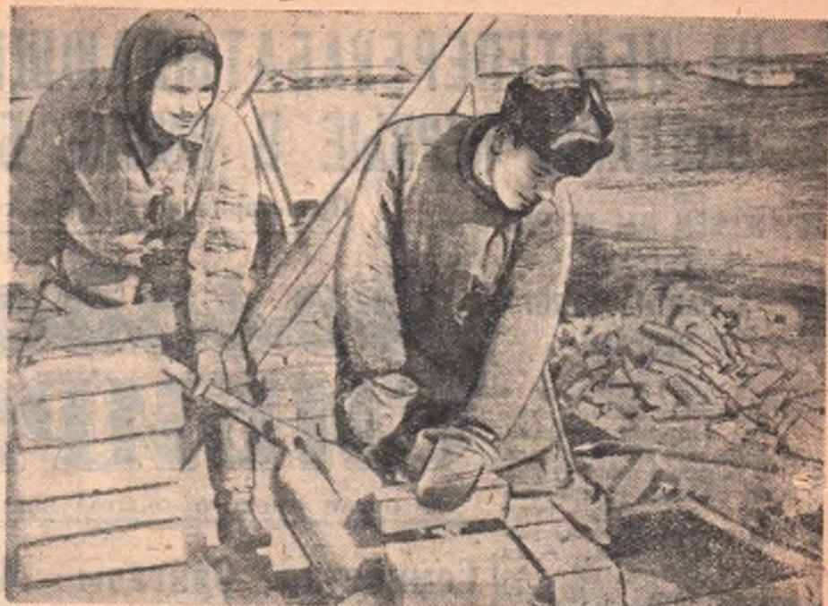
Каменщик Василий Ресенчук и его помощница Вера Козина ведут кладку стен туннельной печи на Калачинском комбинате строительных материалов. Работа у них спорится.
