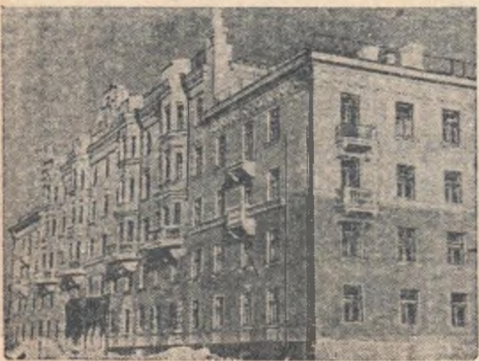
НА СНИМКЕ: новый 56-квартирный дом по улице Герцена — одно из красивейших в Омске зданий. Дом построен скоростными методами силами молодых рабочих стройконтры Центрального района.
