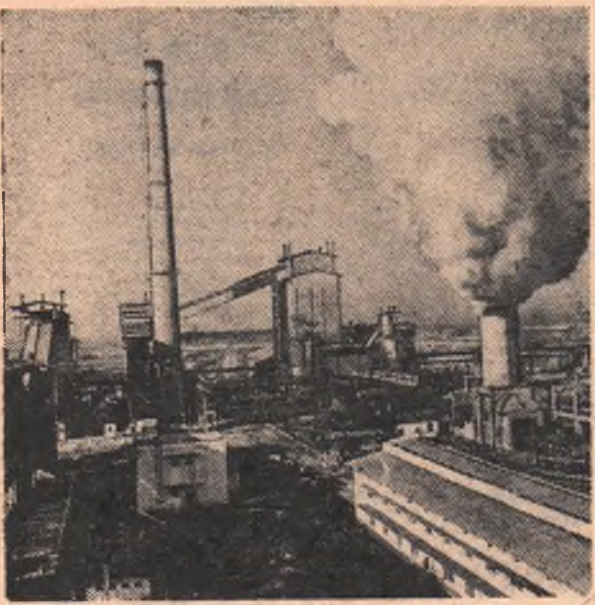
В Индии с помощью советских специалистов в 1957 году началось строительство крупнейшего в Азии комплексного металлургического завода — Бхилаи. Первая очередь завода введена в действие. В феврале выдан первый конк, задута первая доменная печь и получен первый чугун. В марте домна достигла своей проектной мощности. Широким фронтом ведутся работы по строительству мартеновского и прокатного цехов, начинается монтаж следующих конусовых батарей и доменных печей.
