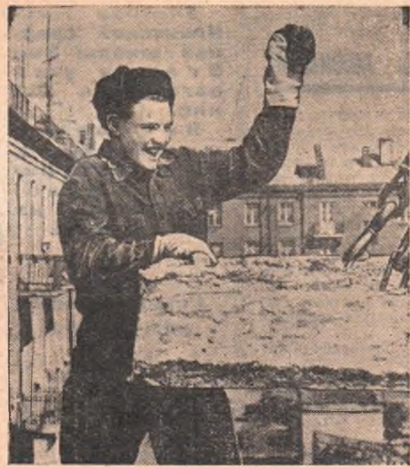
Доброй славой в тресте № 2 пользуется комплексная бригада строителей С. Л. Сулова. Сейчас она возводит новый жилой дом по улице Масленникова. Высоких показателей на строительстве добился член бригады Валерий Тимошенко, которого вы видите на снимке за укладкой перекрытия. Фото Э. Савина.
