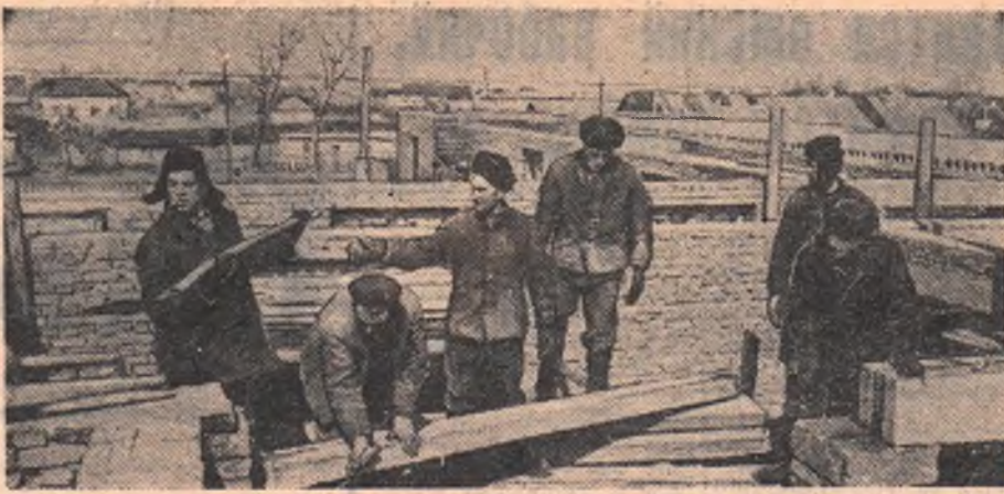
К новому учебному году в селе Ольгино, Москаленского района, откроются двери новой двухэтажной средней школы. Сейчас идет кладка стен здания. Бригада каменщиков, возглавляемая Х. Сартисоном, ежедневно выполняет задания на 150—200 процентов. Фото Э. Савина.
