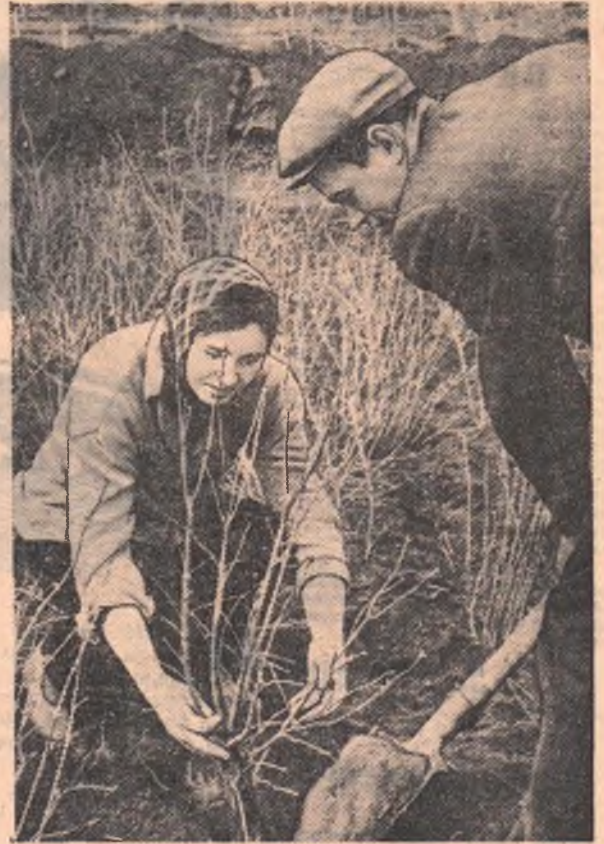
Сотни молодых омичей ежедневно работают на закладке Центрального парка культуры и отдыха на правом берегу Иртыша. НА СНИМКЕ: вулканизаторщики шинного завода комсомольцы М. Анулич и А. Афанасьев сажают сирень.
