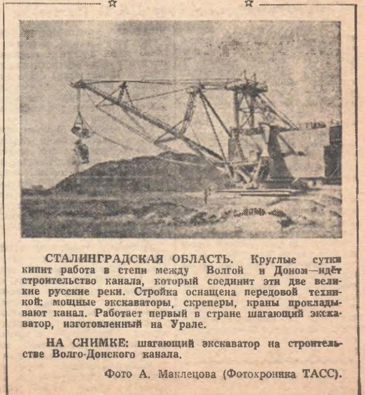
СТАЛИНГРАДСКАЯ ОБЛАСТЬ. Круглые сутки кипит работа в степи между Волгой и Доном — идет строительство канала, который соединит эти две великие русские реки. Стройка оснащена передовой техникой: мощные экскаваторы, скреперы, краны прокладывают канал. Работает первый в стране шагающий экскаватор, изготовленный на Урале.
