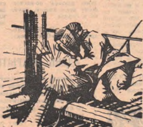
Работает монтажник В. Тесленко.
