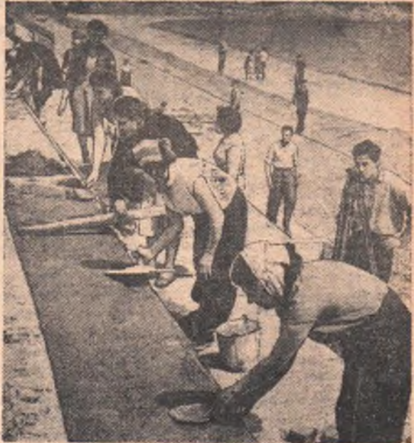
Этот день был воскресным, но штукатуры Саша Попова, Валя Жданова и Полина Головачева, как и многие их товарищи, заняли рабочие места. Правда, не на объектах строительного участка № 2 «Омгорстроя», где они трудятся обычно, а на трибуне стадиона, создаваемого в Парке культуры.
