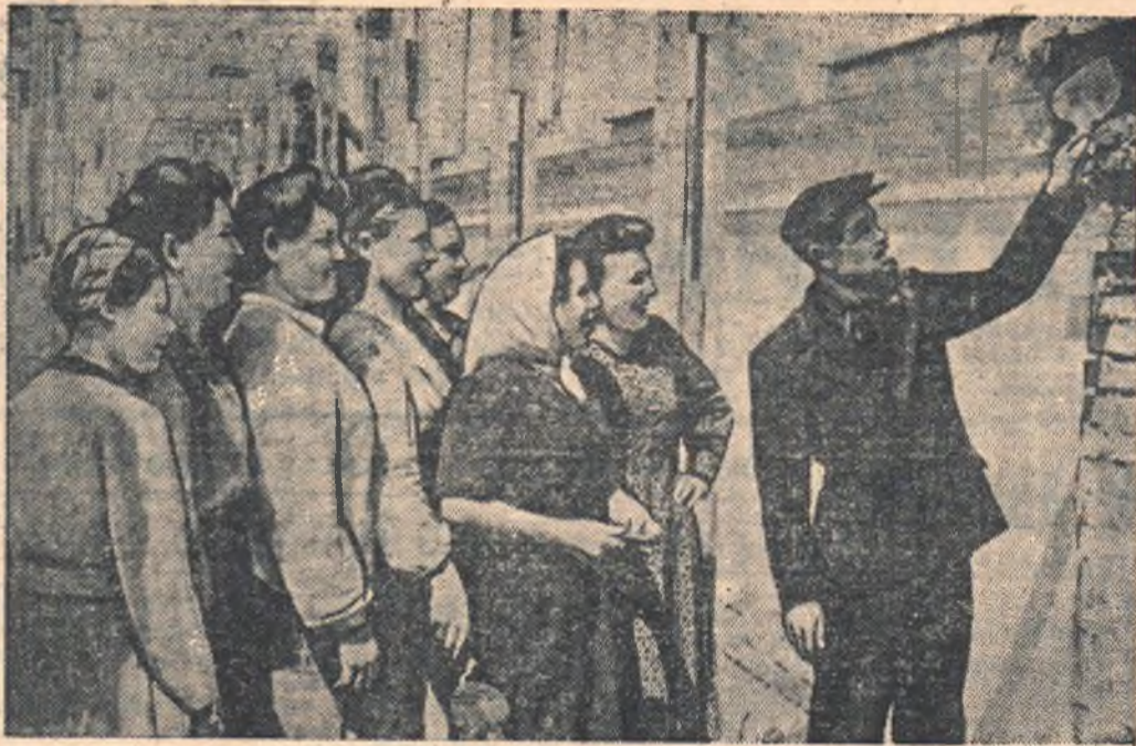
Молодые строители Куйбышевского района г. Омска знакомятся в стахановской школе с передовыми методами работы.
