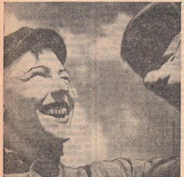
Воспитаник Омского строительного училища № 11 Виктор Лаптев возводит 68-квартирный дом по улице Масленникова. Винтор-каменщик. Он работает в тресте «Омгорстрой», в бригаде Станислава Тимошун. Молодой строитель ежедневно перекрывает нормы выработки. Фото Э. Савина.
