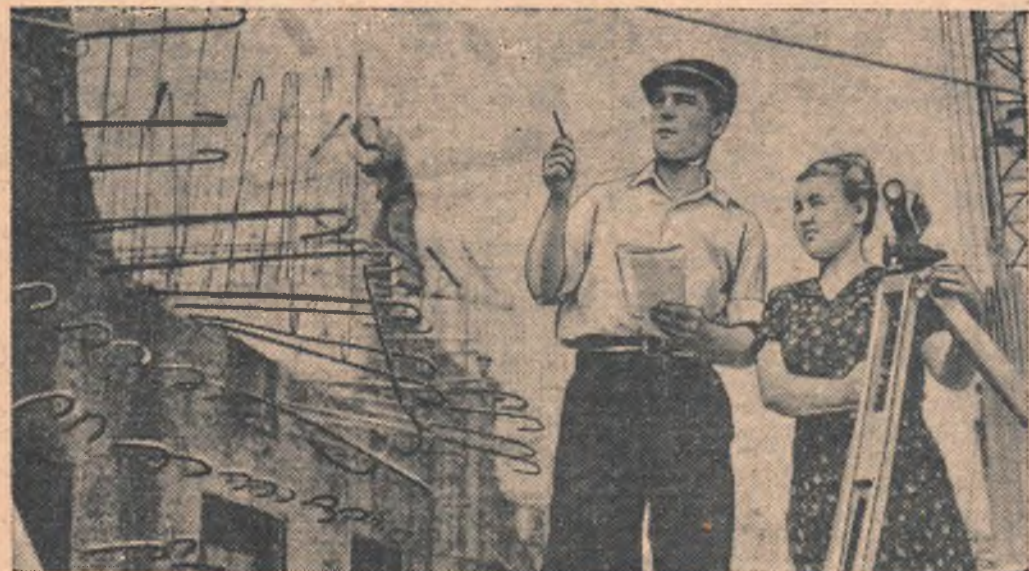
Волгодонстрой. Старший прораб насосной станции Варваровского гидроузла А. Былинкин и техник-геодезист комсомолка З. Крайнева проводят выверку установленных арматурных сварных каркасов перед закладкой их бетоном.
