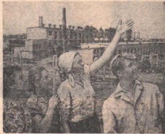
— Во-он, сверху, наша строительная площадка. Там мы и работаем...
