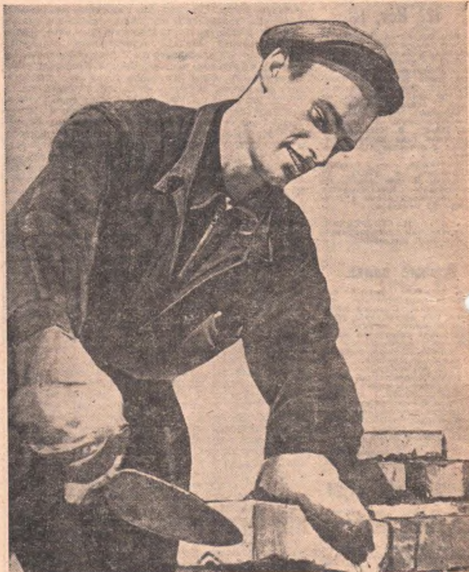
Бригада каменщиков строительного монтажного поезда № 26, возглавляемая И. Новициным, борется за высокое звание колллектива коммунистического труда. Ежедневно члены бригады выполняют задания на 170 процентов. На снимке: бригадир И. Новицкий.
