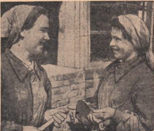
Хорошо трудятся на строительстве 68-квартирного дома по улице Красной путь штукатурки отдела капитального строительства Сибзавода Мария Улаева и Клава Верташенон. Ежедневно девушки выполняют норму на 150—160 процентов.
