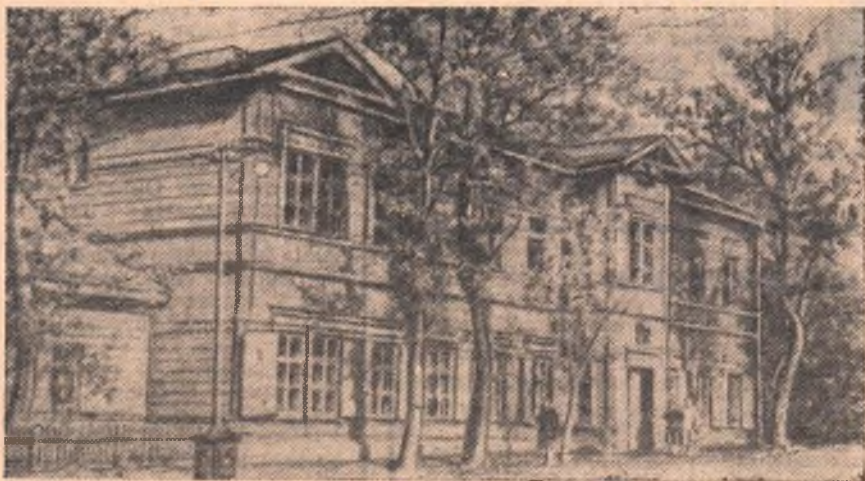
Этот дом — на улице Лобкова, 45 (бывшей Атаманской). Здесь почти шестьдесят лет назад в угловой комнате первого этажа проводила собрания первая омская молодежная группа. Здесь под руководством большевиков устраивались нелегальные собрания железнодорожной и городской молодежи Сергей Молотовников. А в верхнем этаже, ничего об этом не ведая, жил до времени жандарм Перевалов. Снимок П. Чебоксарова.
