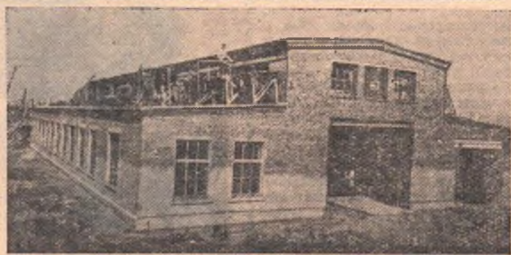
В Розовском совхозе, Русско-Полянского района, заканчивается строительство типовой машинно-тракторной мастерской (МТМ). Здесь будет проходить ремонт весь машинно-тракторный парк совхоза.
