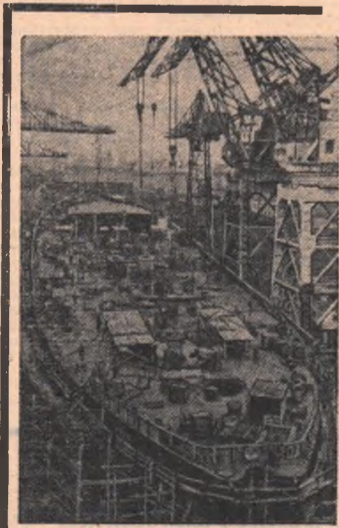
ЛЕНИНГРАД. На строительстве атомного ледокола «Ленин». НА СНИМКЕ: общий вид строительства ледокола.
