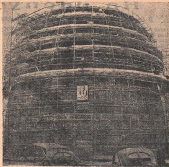
Федеративная Республика Германии. НА СНИМКЕ: строительство атомного реактора в Гархинге (близ Мюнхена). Фотохроника ТАСС.
