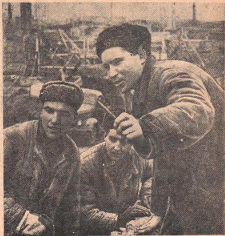
Сталинская область. С каждым днем растут темпы работ на ударной комсомольской стройке семилетки — сооружении стана «1700» Ждановского металлургического завода имени Ильича. Строители уже вынули десятки тысяч кубометров грунта, уложили тысячи кубометров бетона. НА СНИМКЕ: бетонщики управления ТЭЦстрой комсомольцы (справа налево) бригадир Виктор Форман, Петр Заблудский и Демьян Батюк, занятые бетонированием фундамента машинного зала. Они выполняют до двух норм в смену. Фото П. Кашкеля. (ТАСС).
