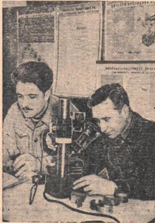
монта и эксплуатации автомобилей, уже сконструировал и изготовил универсальный прибор для тонкой (алмазной) расточки автотракторных вкладышей и втулок распределительных валов.
