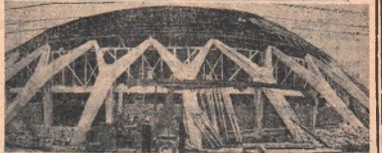
В 1960 году в Риме будут проходить очередные олимпийские игры. В настоящее время в столице Италии идет строительство олимпийских спортивных сооружений. НА СНИМКЕ: строительство зала для соревнований по гимнастике и фехтованию. Фотохроника ТАСС.
