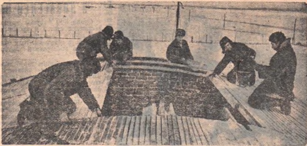
Механизаторы совхоза «Цветочный» заканчивают строительство типовой мастерской. На снимке вы видите, как покрывается крыша мастерской.
