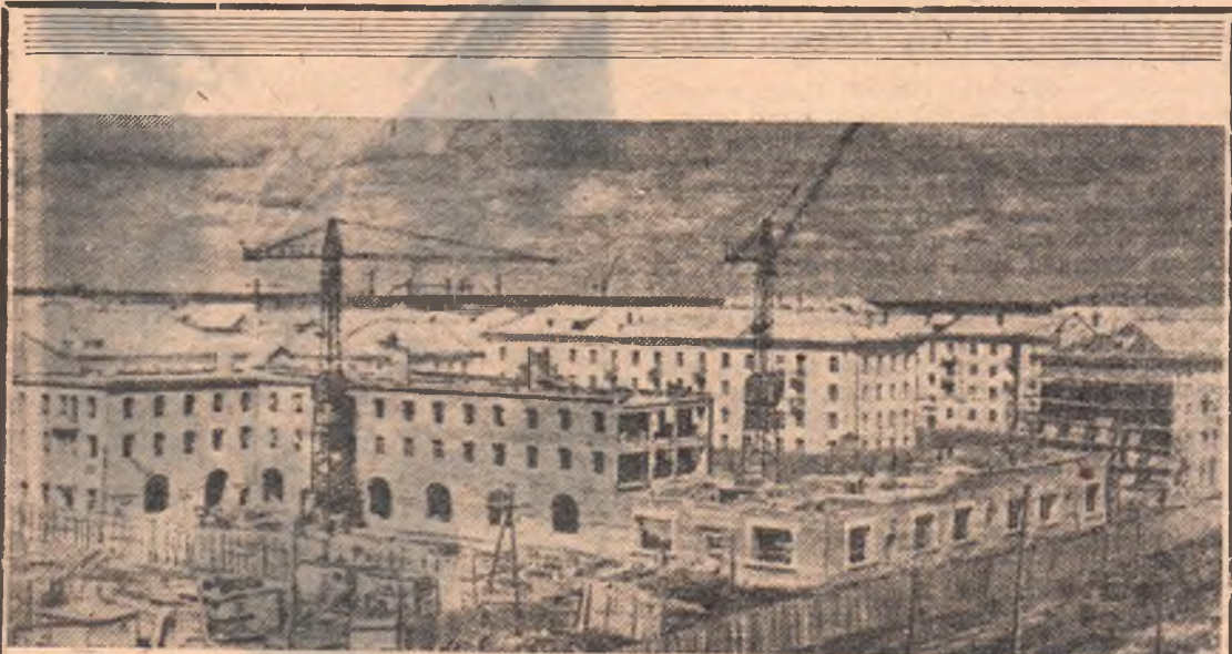
НА СНИМКЕ: застройка проспектов Культуры и Мира в городке нефтяников. На переднем плане строительство 39-квартирного дома, который возводит коллектив первого стройрайона управления «Омкстроя». Фото А. Селько.
